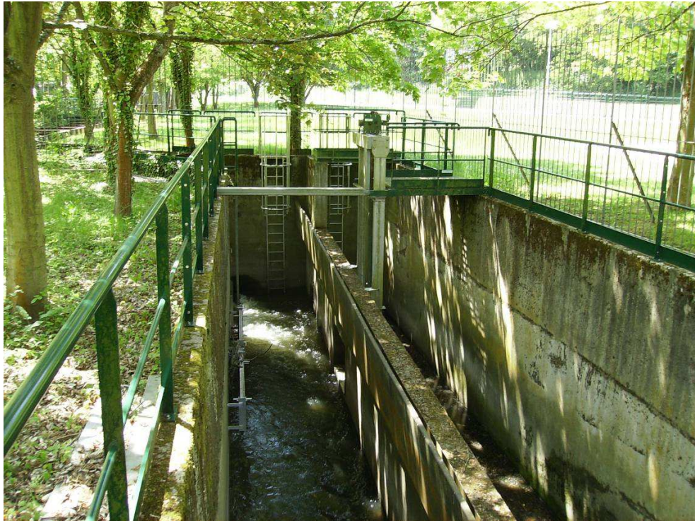
Figure 20 : Ouvrage de partition des débits à l'amont du bassin d'Antony (Source : SAFEGE)
