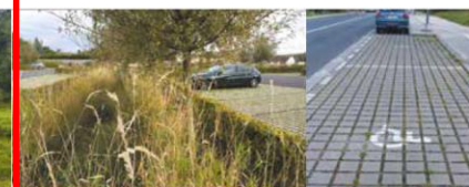
▲ Pavés non jointifs et noue en cœur de parking.
